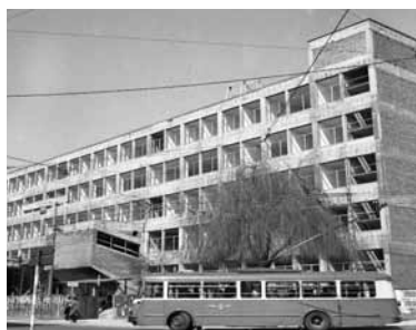
Gradnja stavbe Filozofske fakultete v Ljubljani, 1960. Foto: Edi Selhaus, arhiv MNZS.
